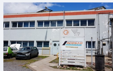
Acceso a la planta de la Cooperativa Metalúrgica 1° de Agosto
