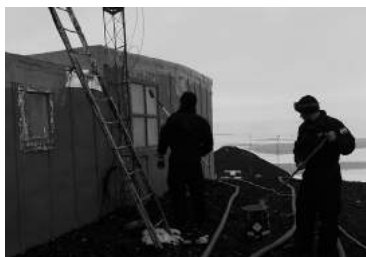
Trabajos de mantenimiento.
