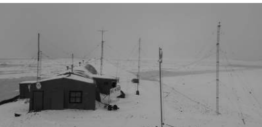
Matienzo – sector ingreso a base y torres de antenas.
