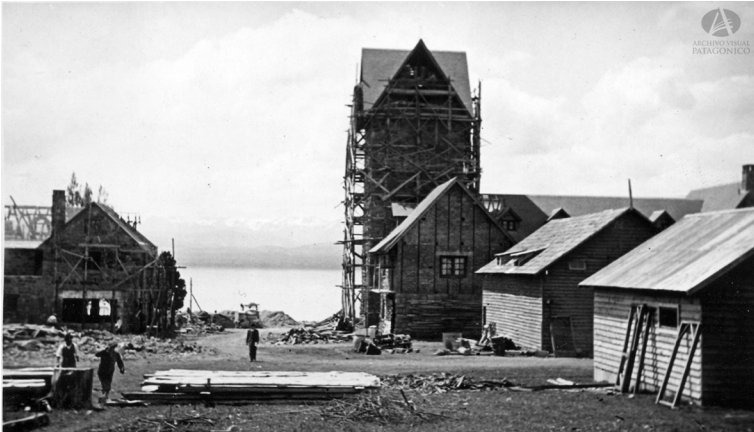
Construcción del centro cívico de San Carlos de Bariloche.
