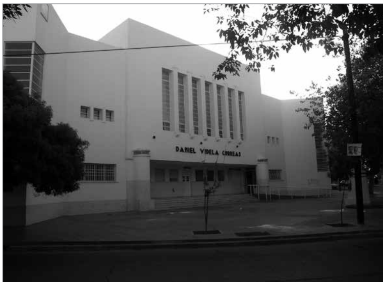
Imagen 4. Escuela Videla Correás, fachada. Foto: Daniela Cattaneo.
