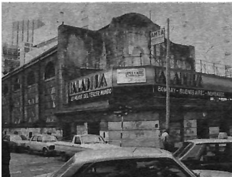
IMAGEN 8. Opción b. Fachada de Paladium en obra. Archivo de Juan Lepes.
